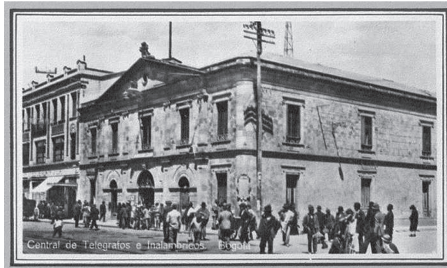
Central de Telégrafos e Inalámbricos. Avenida Jiménez x carrera 7a, Bogotá, ca. 1920. Fuente: Gómez Rodríguez, 2012
