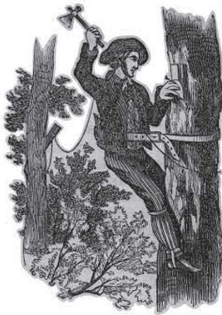
Instalación de una línea telegráfica. Fuente: Gómez Rodríguez, 2012.
